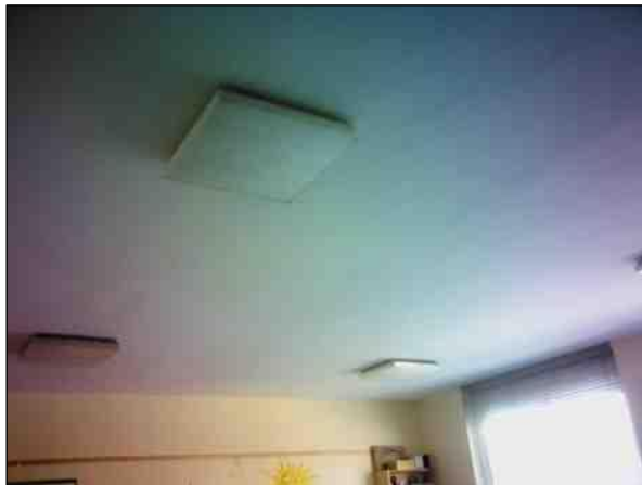
Foto n°1-2 - Individuazione della tramatura caratteristica dell'intradosso dell'Aula 7 al piano primo. Gli elementi portanti sono caratterizzati da una colorazione più chiara mentre il sistema di alleggerimento è contraddistinto da tonalità più scure.
