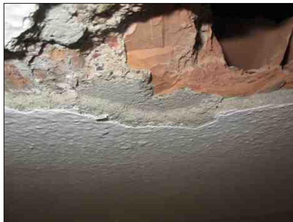
Foto n°10 - Particolare dello spessore dello strato di finitura intonacata.
