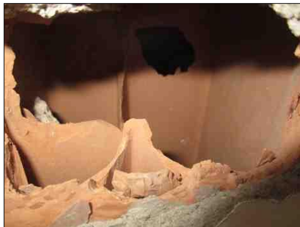
Foto n°8 - Particolare dell'alleggerimento in pignatta di laterizio.
