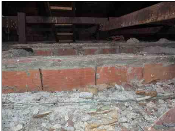
Foto n°9 - Osservazione ed individuazione della Tipologia Solaio 1 attraverso la botola rilevata nel Corridoio al piano primo.
