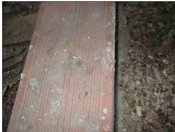
Foto n°10 - Particolare del laterizio armato.
