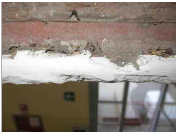
Foto n°11 - Particolare dello spessore dello strato di finitura intonacata.
