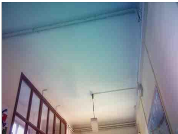
Foto n°5-6 - Individuazione della tramatura caratteristica dell'intradosso del Corridoio al piano terra. E' possibile riscontrare un interasse minore tra le nervature portanti rispetto al solaio sopra riscontrato.
