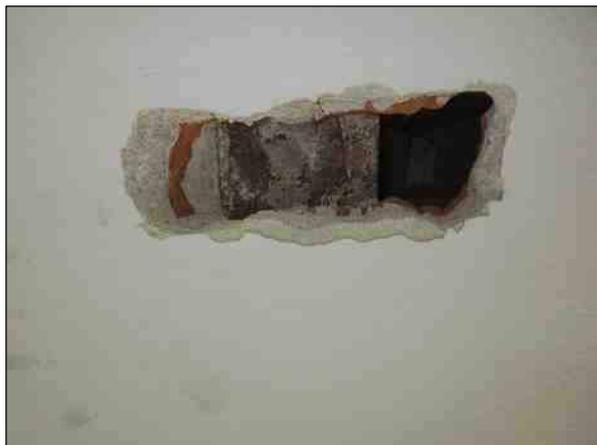
Foto n°11 - Individuazione della Tipologia Solaio I; demolizione eseguita nella Palestra al piano terra.
