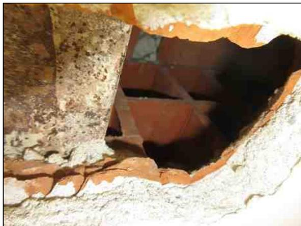
Foto n°12 - Particolare della geometria del blocco di alleggerimento laterale.
