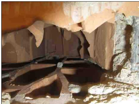
Foto n°15 - Particolare della geometria del blocco in laterizio che costituisce il sistema di alleggerimento del solaio.
