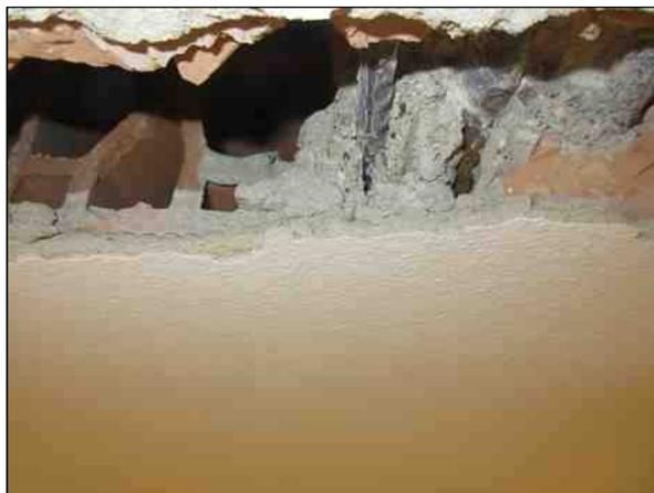
Foto n°17 - Dettaglio dello spessore dello strato di finitura del plafone.
