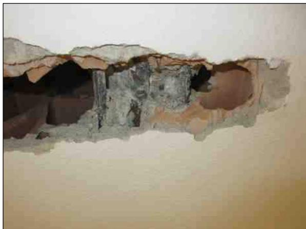
Foto n°16 - Particolare del travetto gettato in opera.
