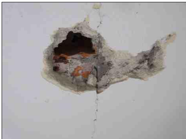
Foto n°3 - Vista generale della demolizione eseguita nell'Ingresso al piano terra.
