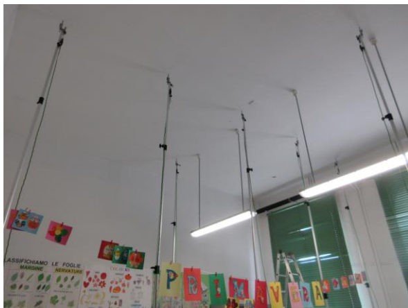
Foto n°1 - Posizionamento dei sensori di misurazione all'intradosso del solaio dell'Aula 5 al piano terra.
