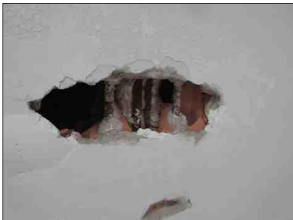
Foto n°1 - Vista generale della demolizione eseguita nell'Aula 7 al piano terra.
