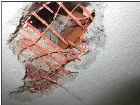
Foto n°1 - Individuazione della Tipologia di solaio oggetto della prova di carico.
