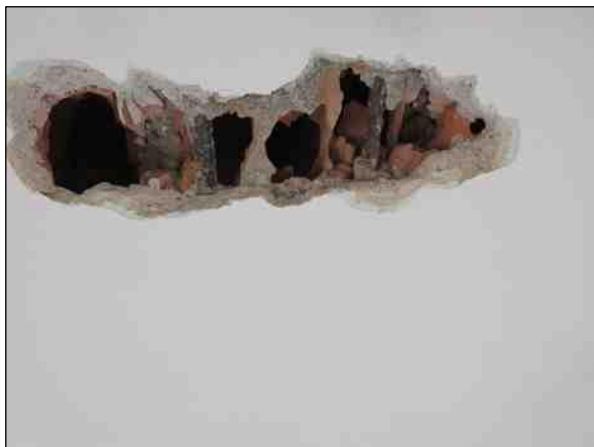
Foto n°3 - Individuazione della Tipologia di solaio.
