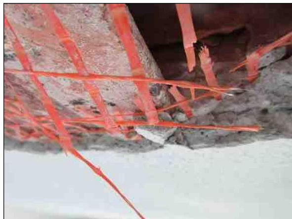
Foto n°2 - Particolare del profilo metallico utilizzato come elemento portante del solaio.
