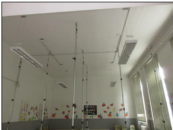
Foto n°1 - Posizionamento dei sensori di misurazione all'intradosso del solaio del refettorio al piano terra.
