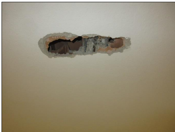
Foto n°3 - Individuazione della tramatura caratteristica dell'intradosso del solaio descritto.
