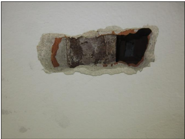
Foto n°1 - Individuazione della Tipologia di solaio oggetto della prova di carico; demolizione eseguita al piano terra.
